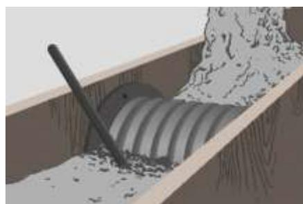
Beton in Futterrohrnähe gut verdichten.
