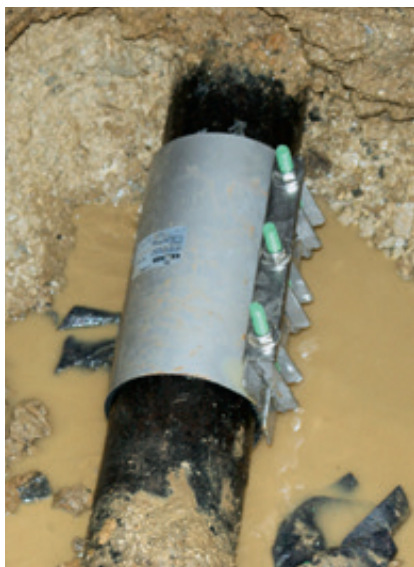
Abb. 3: Die Reparaturschelle im Einsatz
